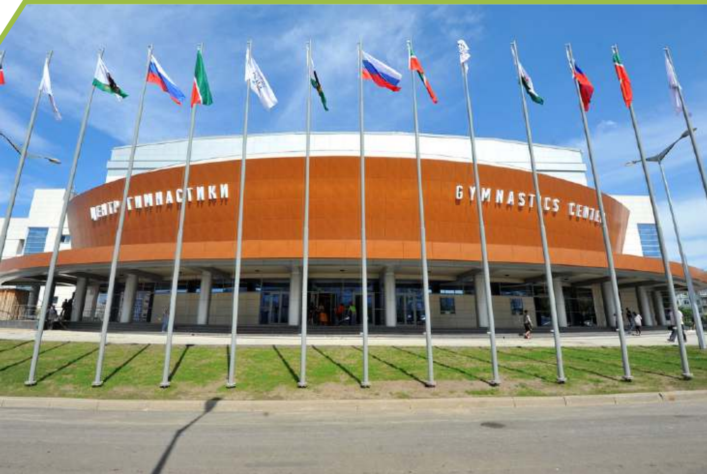
Центр гимнастики по ул. Сыртлановой, г. Казань (Универсиада 2013)
